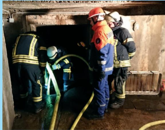
Auspumpen der Quelfassung durch die Feuerwehr
