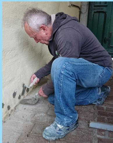
Die angekündigten Absicherungsarbeiten gegen aufsteigende Feuchtigkeit in der Tordurchfahrt der Torburg sind durch Einbringen einer Silikon-Mikroemulsion inzwischen durchgeführt worden, inzwischen sind auch die feuchtigkeitsbedingten Schäden am Wandputz beseitigt. Wir danken dem Lions Club Bensberg-Königsforst und der Stadt Rösrath für die finanzielle Unterstützung, der Firma Seyfert für die effiziente und kostengünstige Durchführung sowie natürlich Nik Sturm, der das Ganze organisiert hat!
